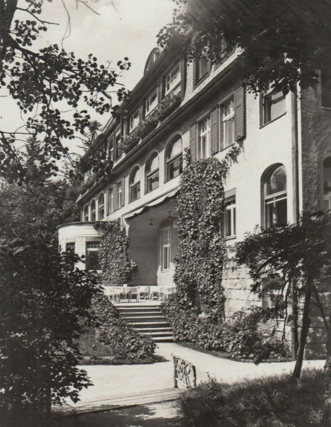
Pension Schindler w 1934 roku, późniejszy DW Raszyn, obecnie hotel Bosman w Szklarskiej Porębie
