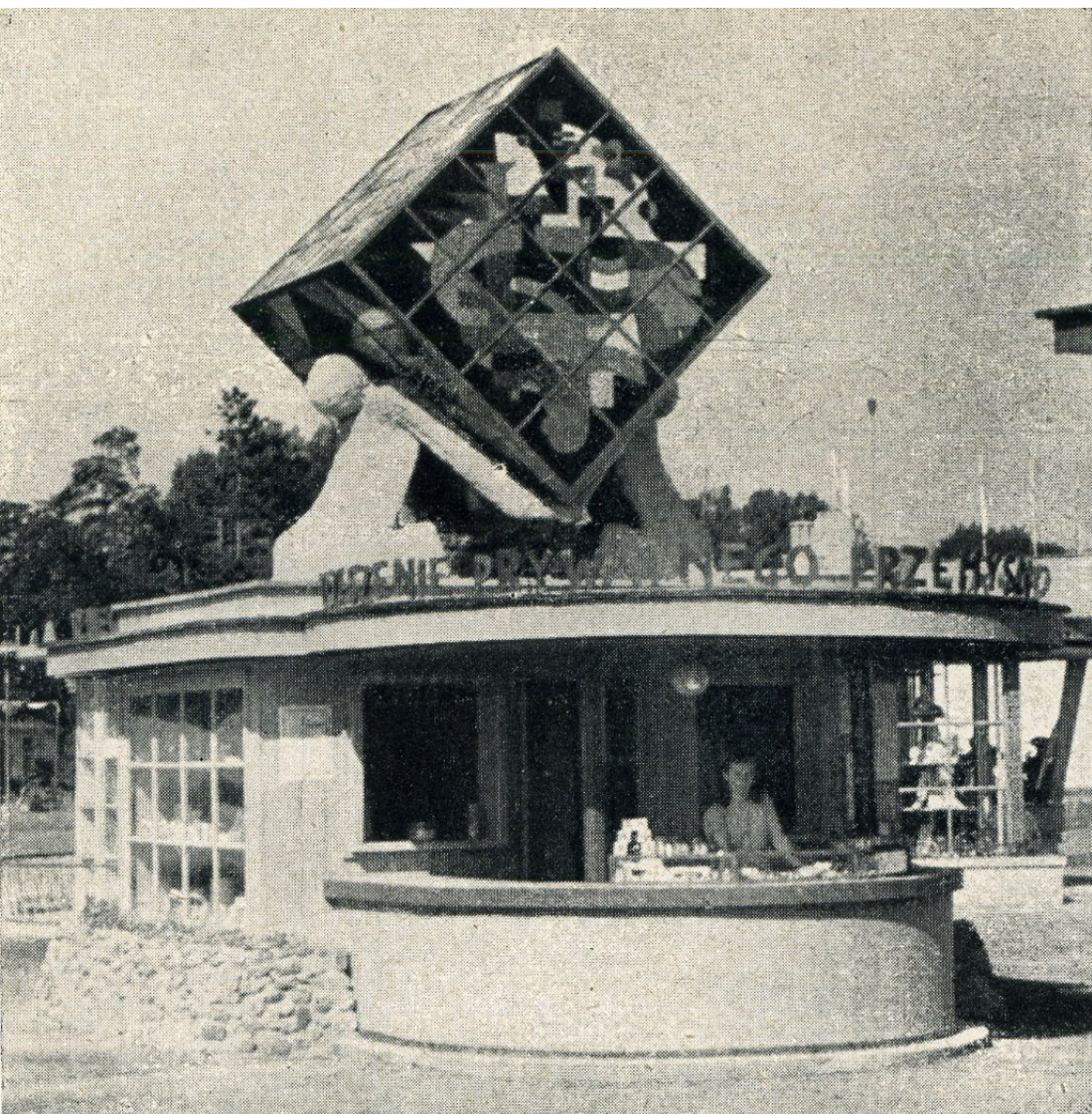
Kiosk Zjednoczenia Przemysłu Prywatnego / źródło czasopismo "Architektura", 1948
