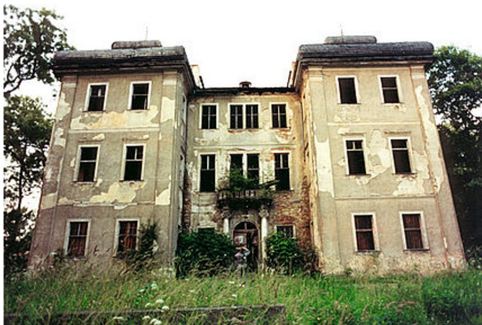
Duży Pałac w Łomnicy przed (powyżej) i po remoncie (na następnej stronie).
