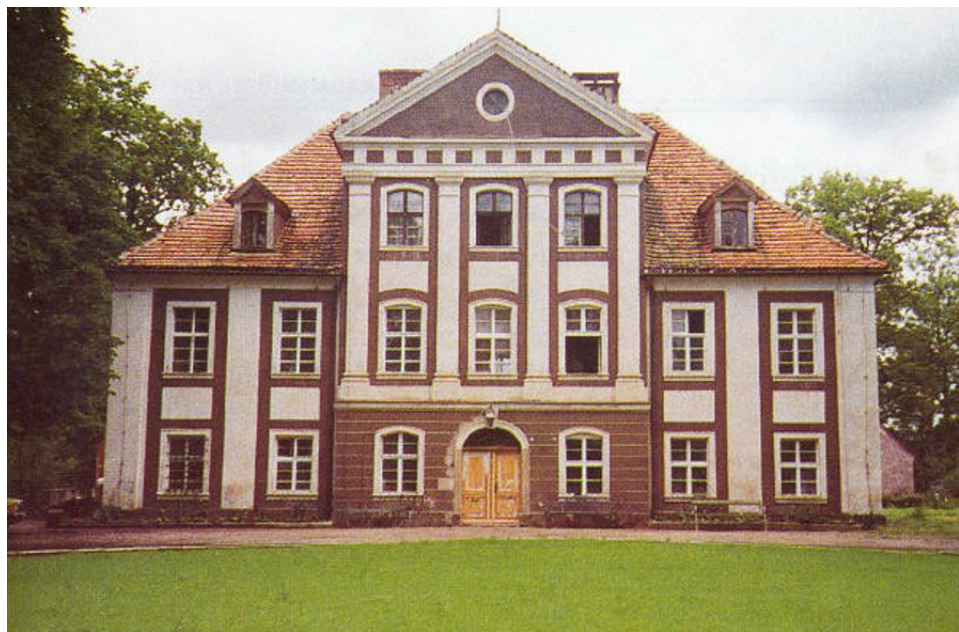
Mały Pałac (Dom Wdowy) przed (powyżej) i po remoncie (na następnej stronie).
